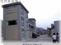
擴建後北竿衛生所
